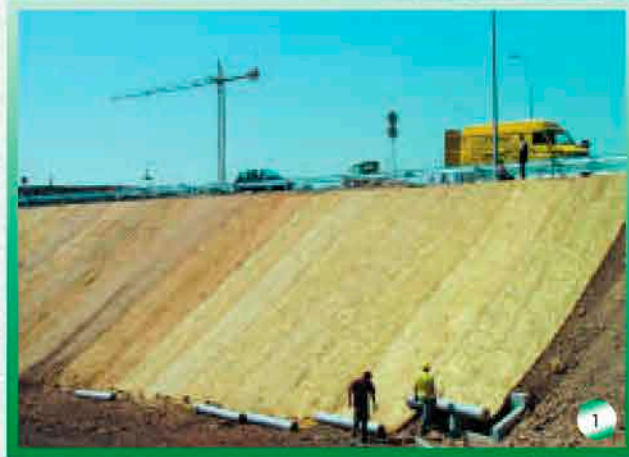
Vesikasvimatto moottoritien pientareella on rullattu samalla kertaa uuden COVAMATS-PLUS san kanssa. Pohja on ravintoköyhää maan ainesosaa.
