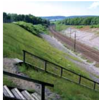
GREENFIX f 3 Covamat kuusi viikkoa asennuksen jälkeen.
