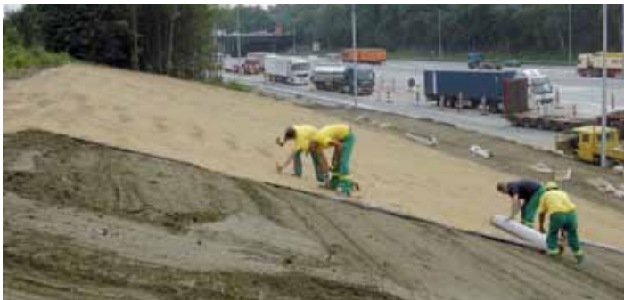
Noin 60 000 neliometriä Covamat fresh -mattoa on asennettu rengastien ympärille Antwerpen/ Belgia.
