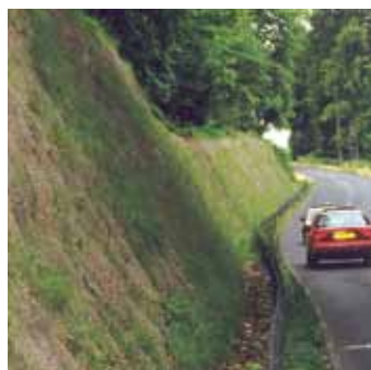
Luiska on katettu GREENFIX Rockmat - matolla. Kuusi viikkoa asennuksesta.
