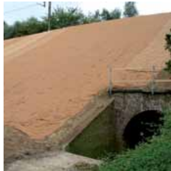
Luiskasuoja GREENFIX Eromat asennettuna jyrkälle luiskalle rautatien reunassa.
