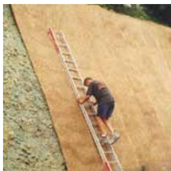
GREENFIX Rockmat type 5D on asennettu kaltevuudeltaan 65 asteiseen luiskaan.
