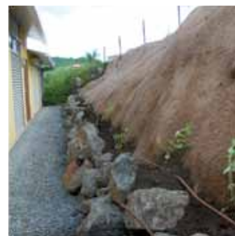
Onnistuneesti asennettu GREENFIX Rockmat type 6D Uudessa Caledoniassa.
