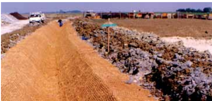
Moottoritien luiska on eroosiosuojattu Covamat plus -matolla Lissabon/ Portugali.
