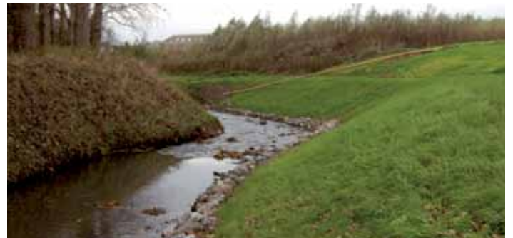
Puron varrella Embankment Mat - matolla suojattu luiska, joka on kylvetty asennuksen jälkeen.
