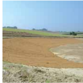
Projektin GREENFIX Eromat tulvialtaassa (asennuksen aikana)
