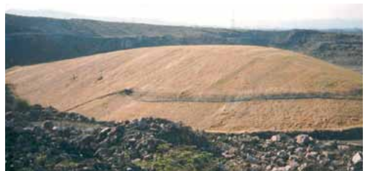
Jäteasema on peitetty eroosiosuojalla Covamat plus .
