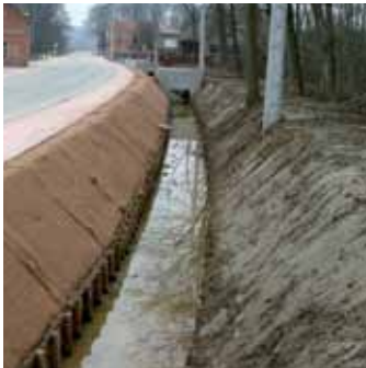
Luiskasuoja GREENFIX Eromat asennettuna salaojan reunoja pitkin.
