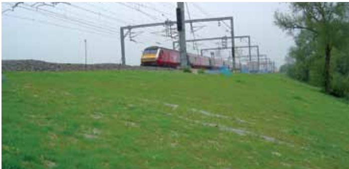
Kasvillisuuden vakiinnuttaminen ja jyrksijöiltä suojaaminen GREENFIX f 3 Rockmat - matolla.
