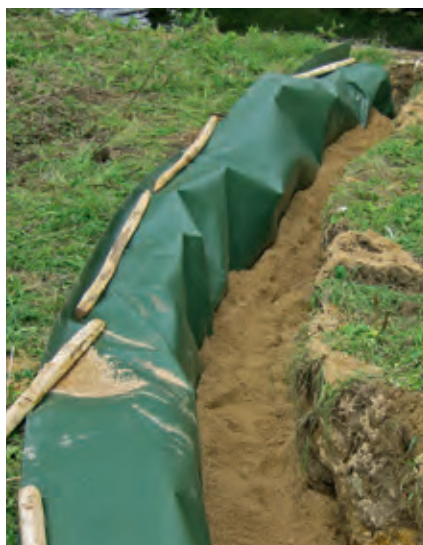
Asennus jossa kokonaisvaltainen Plantex® Platinum ratkaisu, sekä juurakoiden sivustasulku Plantex® RootBarrierillä.
