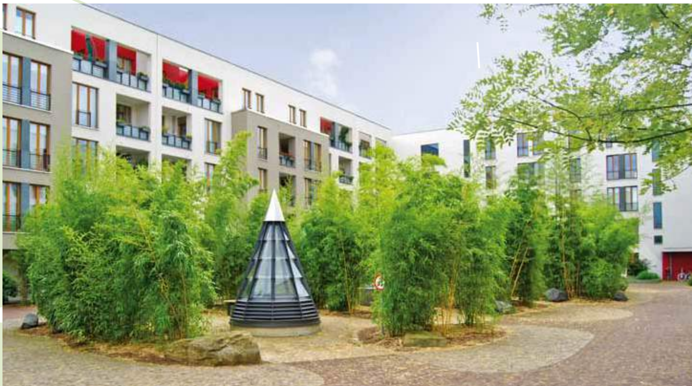
Stabilodrain® SD 30 levyjä on asennettu koko maanalaisen autotallin päälle.
