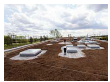
Asennettu kasvialusta "Kivikkotyypin kasvit".
