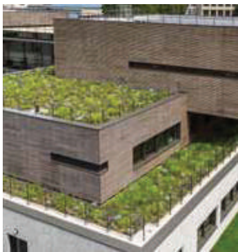
Järjestelmäratkaisu "Kasteltu ekstensiivinen viherkatto" Ratkaisu biologisesti monimuotoisille viherkatoille alueilla joilla pitkiä kuivia kausia
