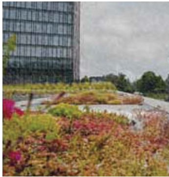
Järjestelmäratkaisu "Hulevesien hallinta katolla" Hulevesien viivyttäminen viherkaton avulla
